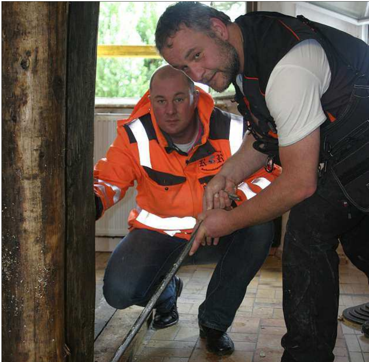
Ohne Atemschutz nur fürs Foto: Sascha Kannenberg (l.) und Kai Schmitz, beide aus über 700 Kilometer angereist, sorgten bis dato in rund 40 Häusern für entschlammte Rohre und Schimmelpilz-Abwehr. – Foto: Karl
