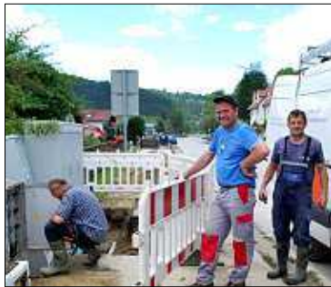
Nach dem Hochwasser war Großeinsatz für den Trupp der E.ON in Erlau: Bis Freitag hatten 15 Mann die Stromversorgung des Ortes wiederhergestellt.
