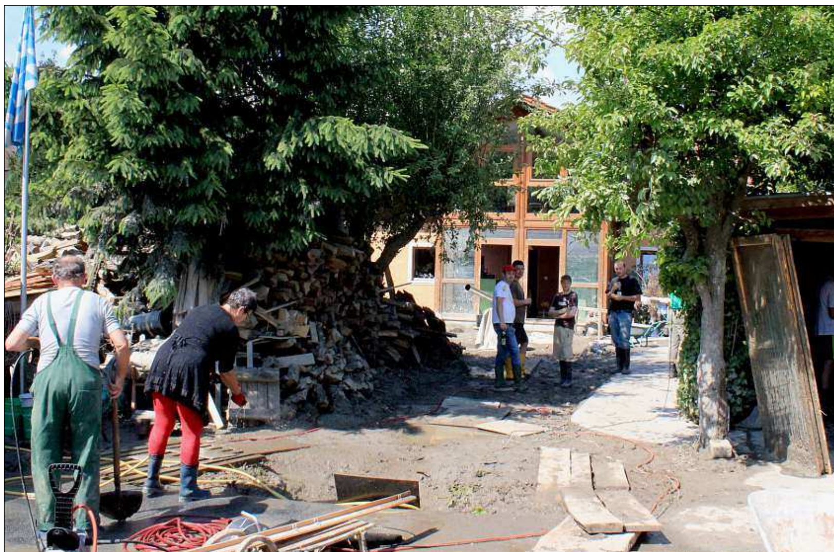
Das Anwesen von Manfred Seidl in Erlau (Lkr. Passau) nach der Flut: Das Haus hatte er zuletzt nach dem Hochwasser 2002 renoviert. Die Jahrtausendflut stand bei ihm bis zu zwei Meter hoch. Der Wintergarten und die Werkstatt sind zerstört, ebenso Fenster und Türen, Hausrat und Mobiliar. Seit der Pegel sank, sind die Familie und Helfer am Aufräumen. – Fotos: Schützeneder
