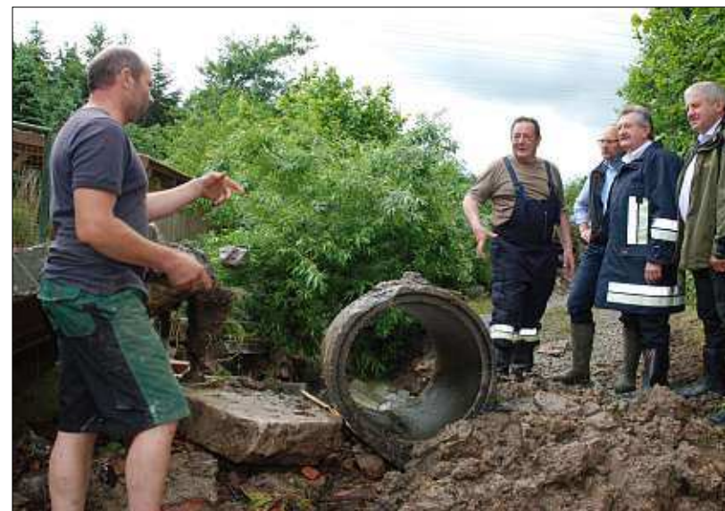
Das Rohr war völlig verstopft: Georg Anzenberger jun. erläutert (von rechts) Bürgermeister Georg Krenn, Landrat Franz Meyer, 2. Bürgermeister Christian Gödel und Feuerwehrkommandant Karl Bachhuber die Schäden an seinem Bauernhof in Hattenham. – Fotos: Baumgartl
