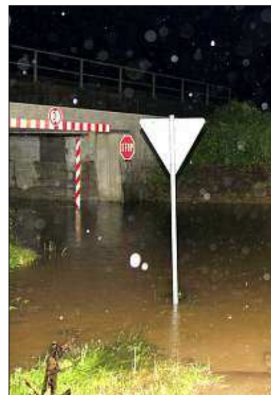
Unter Wasser stand nach dem heftigen Gewitterregen die Durchfahrt unter der Bundesstraße 8 bei Witzling. – Foto: Sigl
