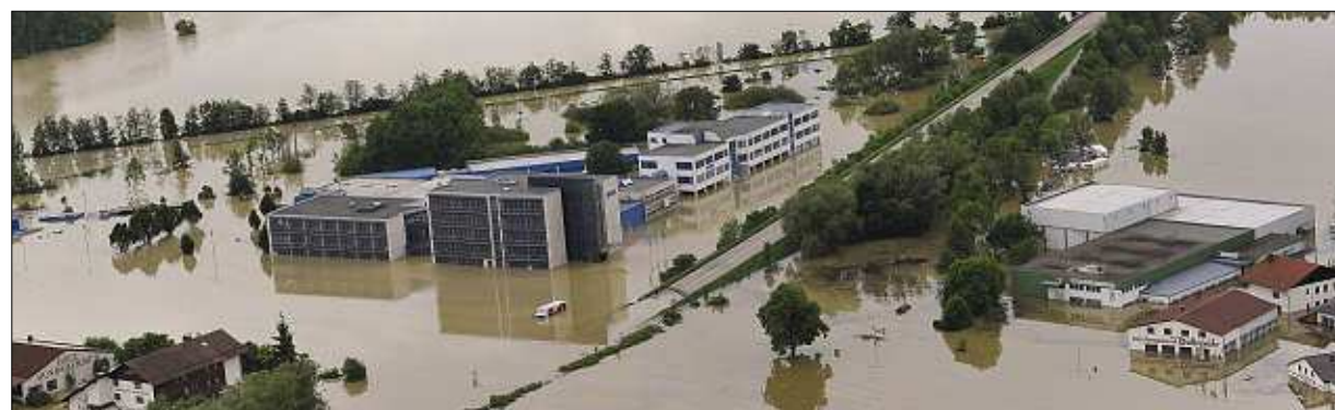
Bis zu 2,40 Meter tief im Wasser standen vergangene Woche die Firmengebäude von Innstolz-Frischdienst (rechts). Bei den YIT Germany-Gebäuden (links im Hintergrund) reichte das Wasser bis auf 1,60 Meter hinauf. – Foto: Binder
