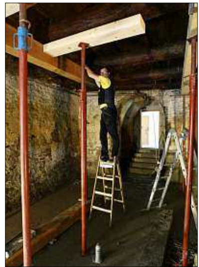
Stützungsmaßnahme in einem Haus an der Fischmarktgassee nahe dem Donau-Ufer. – Foto: Jäger
