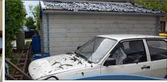
Der Hagel hatte in Oberbayern zahlreiche Autos beschädigt.
