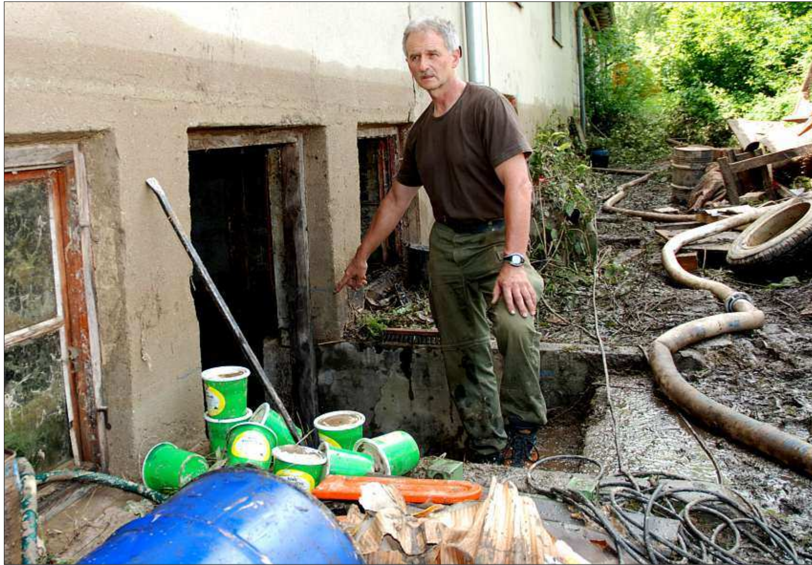
Zwei Hochwasser-Marken hat Josef Krautloher an der Kellertür seiner Sägewerkshalle bei Sandbach: Vor einer Woche schwappte das Donauwasser bis Mitte Türhöhe. Am Sonntagabend kam das Wasser nicht aus dem Fluss, sondern vom gegenüberliegenden Berghang und setzte den fast 400 Quadratmeter großen Kellerraum bis zur Decke unter Wasser – der feuchte Putz bildet die zweite, neue Hochwasserlinie.
